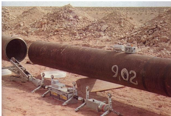
Figuur 17 – De kwaliteit van de lasnaden bij het aanleggen van een pijpleiding is te controleren met een \gamma -bron. Deze bron zit op een robotvoertuig (dat nu nog op de voorgrond buiten de pijpleiding staat) dat door de pijpleiding kan bewegen. De door de lasnaad doorgelaten \gamma -straling wordt buiten de pijpleiding gedetecteerd.
