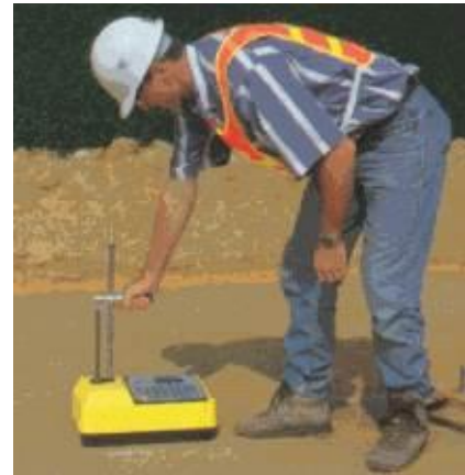
Figuur 19 – Bij de aanleg van een weg is de dikte van de asfaltlaag te meten met behulp van terugstrooiing van \gamma -straling.
