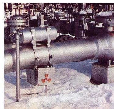
Figuur 9 – Stralingsbron op een olieraffinaderij voor het injecteren van de tracer in de pijpleiding.
